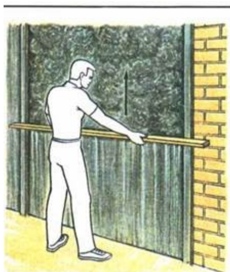
Рисунок 8 – Разравнивание раствора правилом по маякам.
