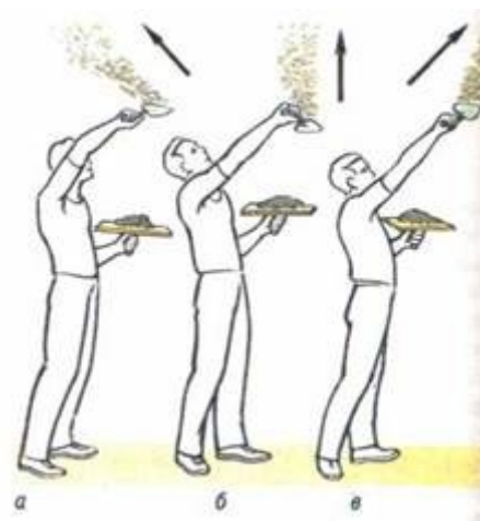
Рисунок 5 – Нанесение раствора кельмой на потолок: а - через плечо; б - над собой; в - от себя.
