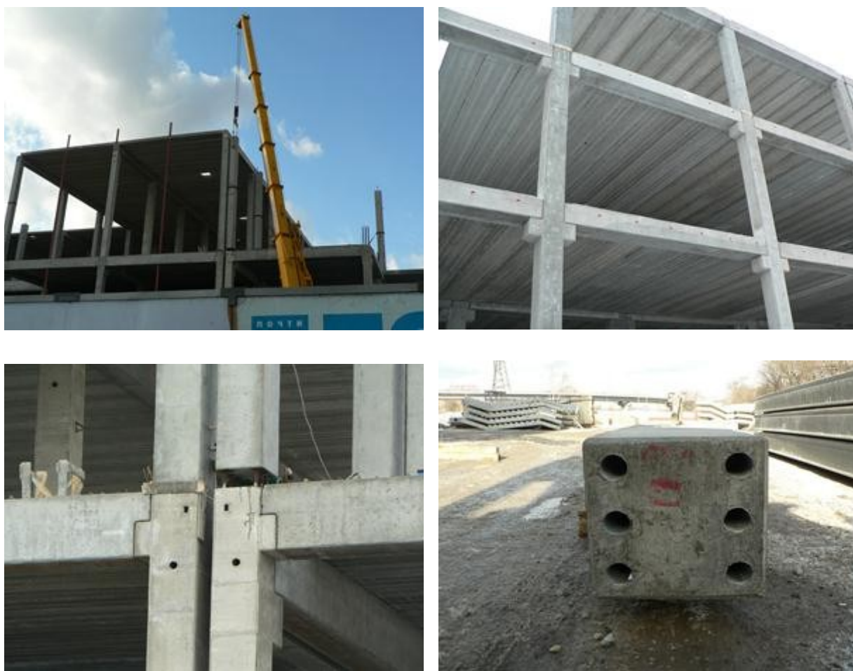
Рисунок 1 - Возводимое здание в сборном железобетоне
