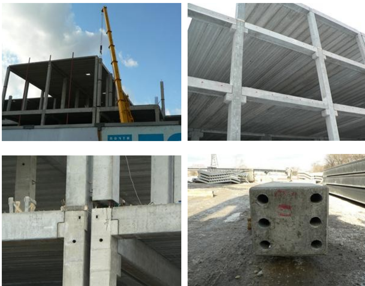
Рисунок 1 - Возводимое здание в сборном железобетоне
