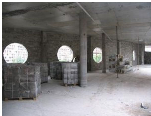
Рисунок 2 - Возводимое здание в монолитном железобетоне
