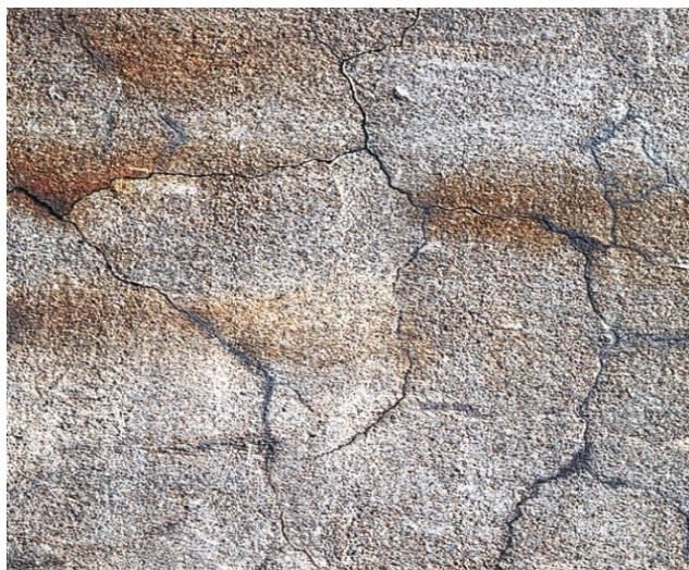
• Рисунок 2 – Типичные повреждения фасада
