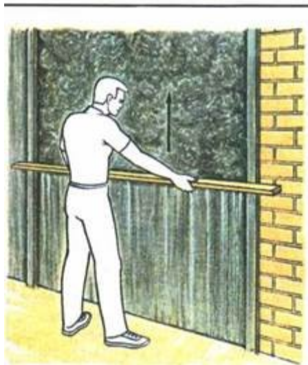
Рисунок 8 – Разравнивание раствора правилом по маякам.
